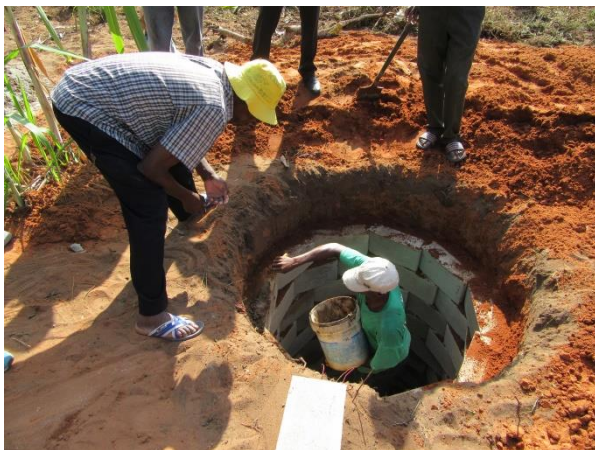
Bau der ersten Latrine im Quartier Muchabje
