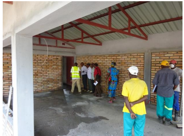
Abb. 4: Besichtigung der Baustelle
