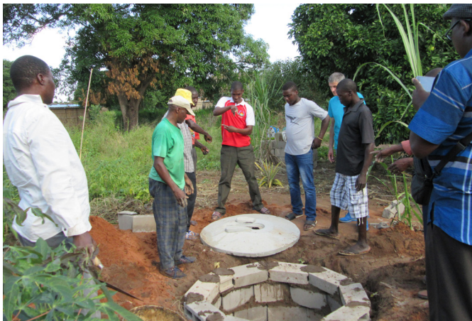
Bau einer Latrine
