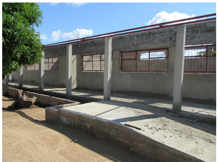
Aktueller Stand der Baustelle
