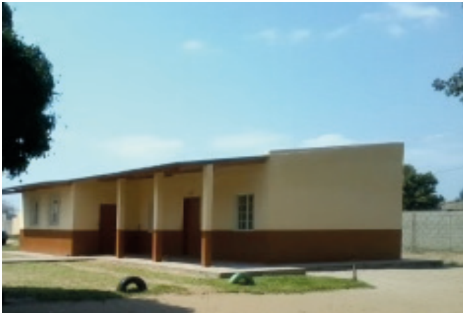
Escolinha Solidariedade nach den Erneuerungsarbeiten
