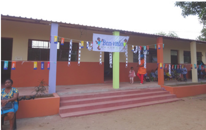
Abb 1: Neues Gebäude Gemeinschaft Tsalala
