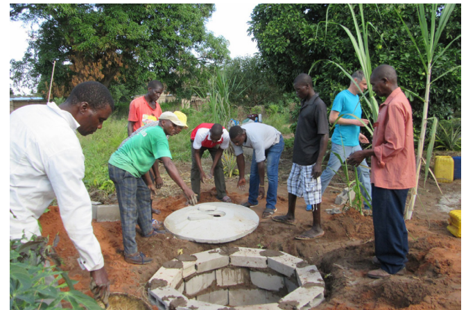
Aufbau von Latrinen
